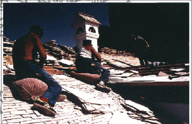
Abb. 29 Dachdecker beim Verlegen des Legschiefers
